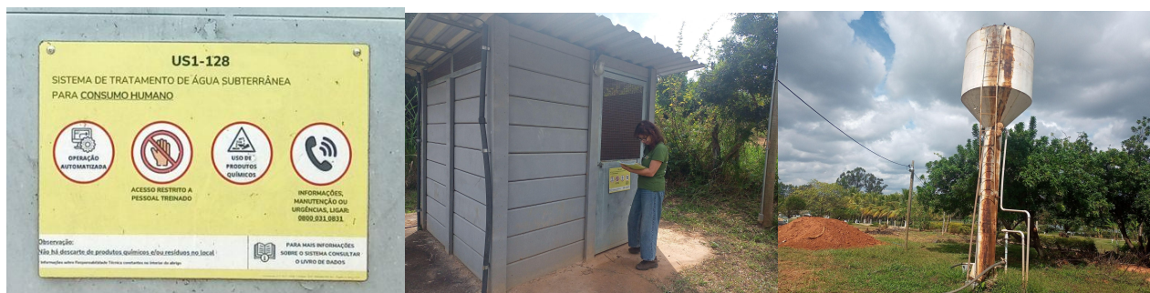
Figuras 10, 11 e 12: Sistema de Filtragem US1-128 - Comunidade La Poveda, Felixlândia/MG
