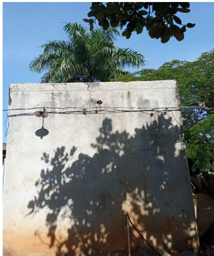
Figura 11 - Estrutura que sustentava o reservatório de água para irrigação por gravidade. Foto: Instituto Guaicuy.
