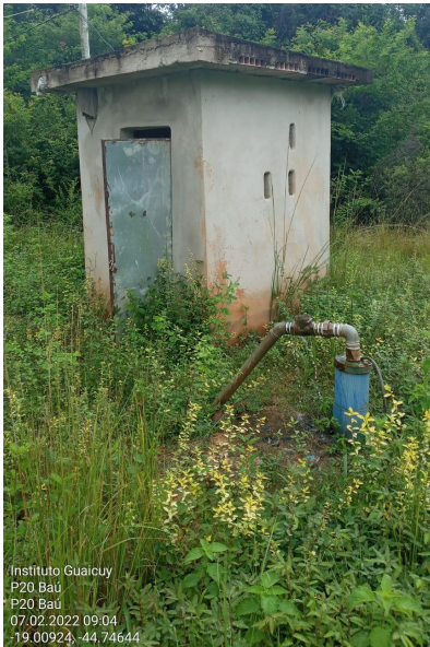
Figura 2: Poço comunitário I (próximo ao rio Paraopeba)
